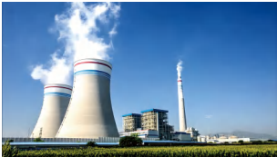
热电行业 Thermal Power Industry
