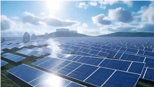
光伏新能源 Solar PV New Energy
