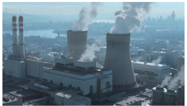
热电行业 Thermal Power Industry
