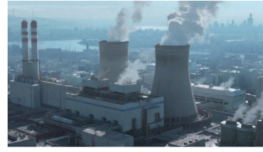
热电行业 Thermal Power Industry
