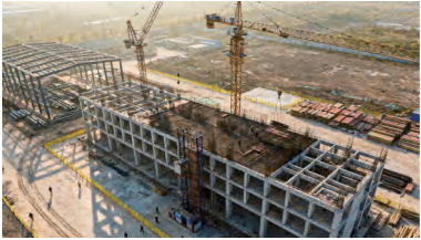
建筑工地 Construction Site
