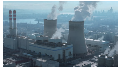
热电行业 Thermal Power Industry
