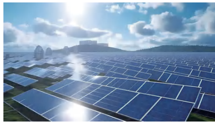
光伏新能源 Solar PV New Energy
