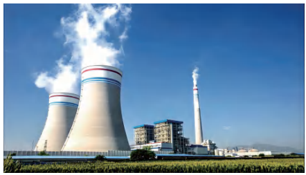
热电行业 Thermal Power Industry
